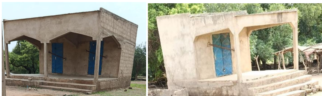
Figure 33. Magasins situés dans une zone inondable, avec rez-de-chaussée surélevé, à Haba, commune de Bartiébougu.
